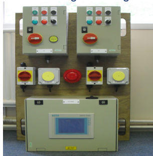
Bitumen discharge area
